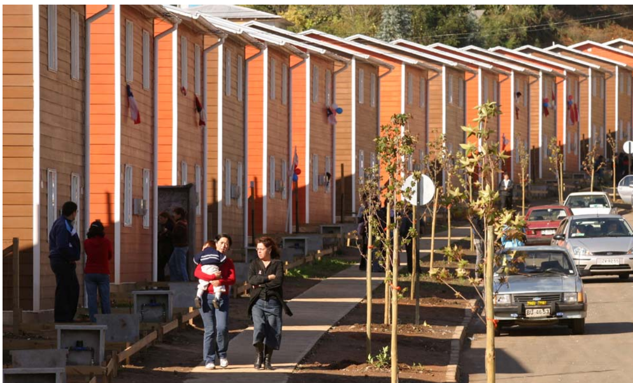
Viviendas del Fondo Solidario de Vivienda, Región del Biobío
